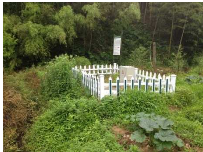
江西省萍乡市安装现场
